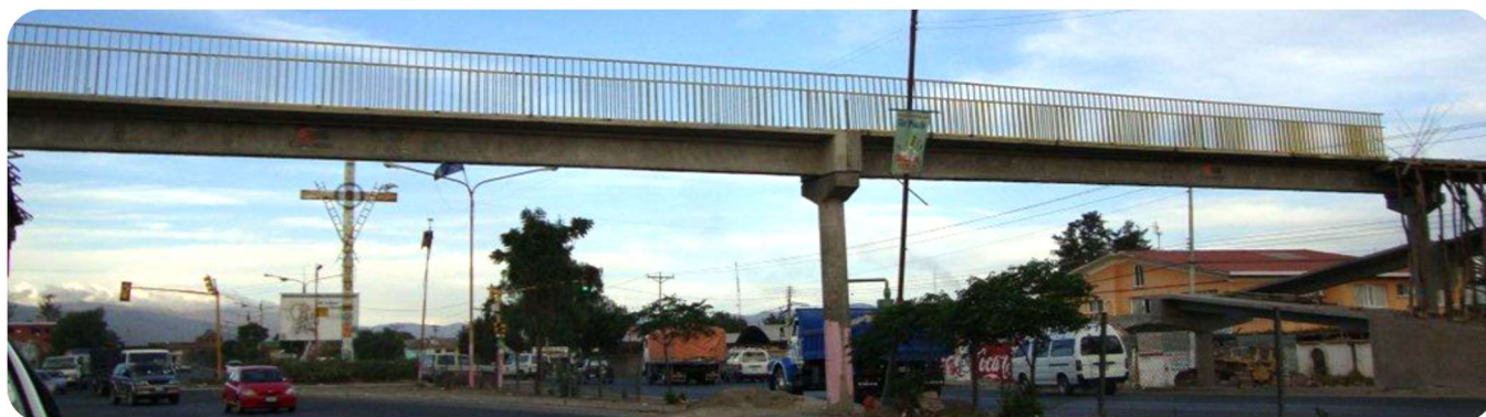
Pasarela en Quillacollo, Cochabamba
