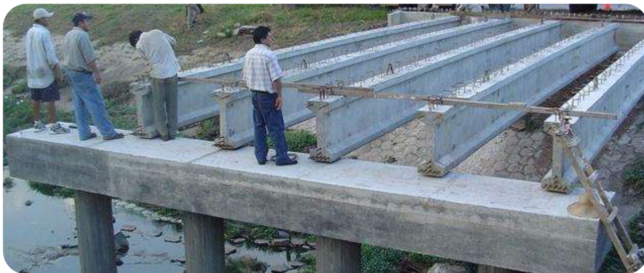
Puente San Aurelio, Santa Cruz
